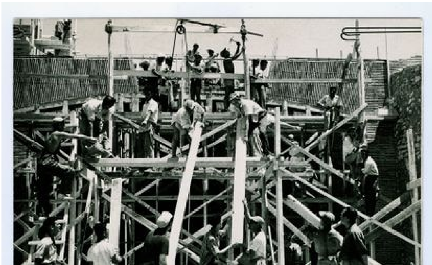
Voluntarios del SUT trabajan en la construcción de un edificio en Alicante en 1957. ASOCIACIÓN DE AMIGOS DEL SUT
